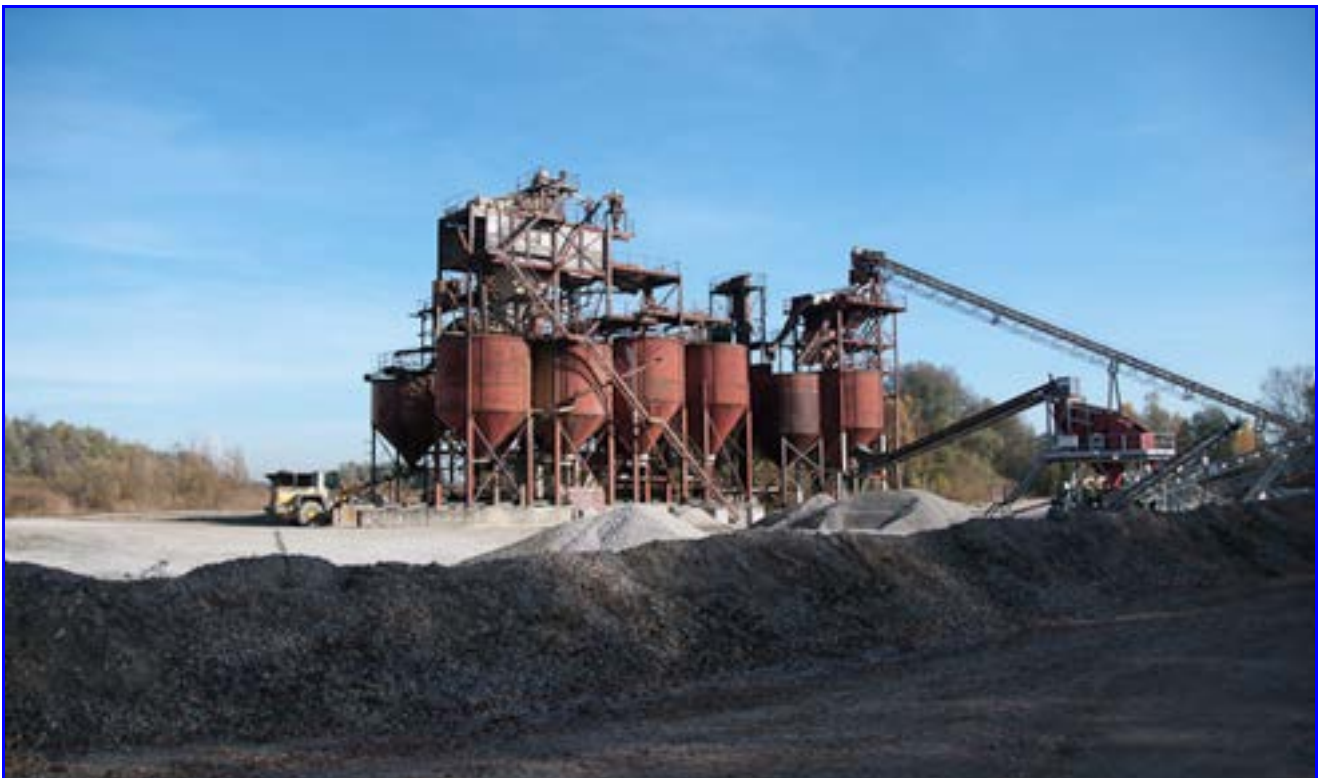
Abb. 59: Das alte Kieswerk Vollmer in seiner ursprünglichen Größe.
