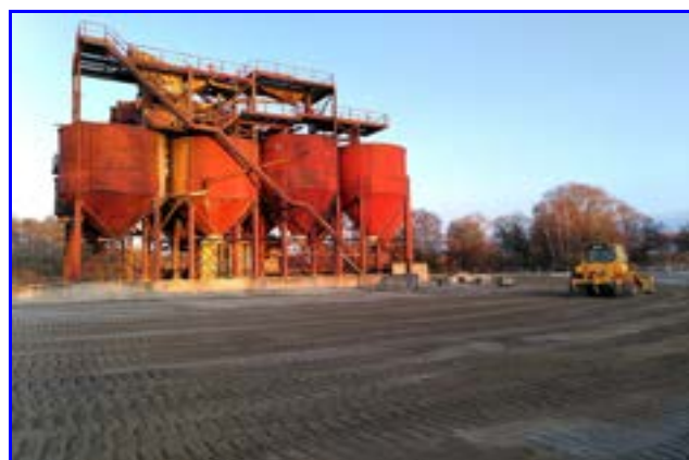
Abb. 23: Planieren der Fläche um das alte Kieswerk.
