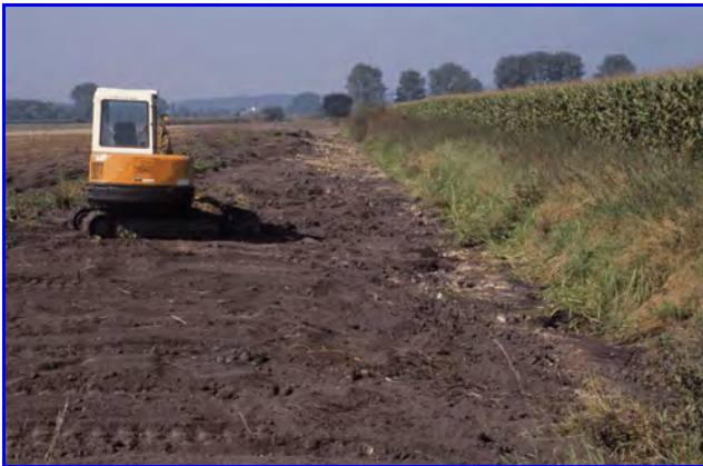
Abb. 34: Einseitige Abflachung eines Entwässerungsgrabens in der Brenzaue.
