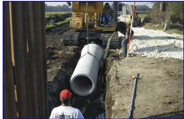
Abb. 18: Verlegung der Rohre der Nauleitung.
