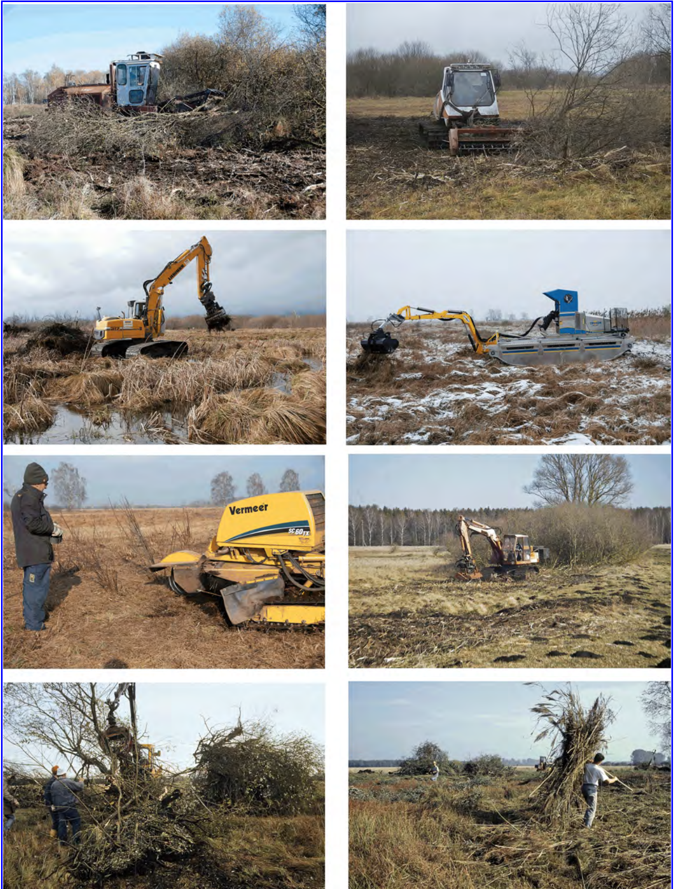
Abb. 10: Entbuschungstechniken: verschiedene Fräsen, unterschiedliche Bagger, Seilwinde und immer wieder Handarbeit.
