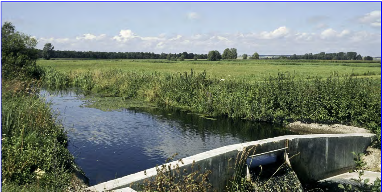
Abb. 72: Ein schon fast historisches Bild: Ein Wehr während des einjährigen Grenzgrabenstaus in den Jahren 199/97 mit Blick auf die Asselfinger Wiesen in Baden-Württemberg, dem hier besprochenen Projektgebiet.
