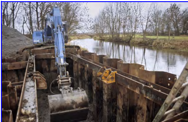
Abb. 17: Bau des Entnahmbauwerkes an der Nau.
