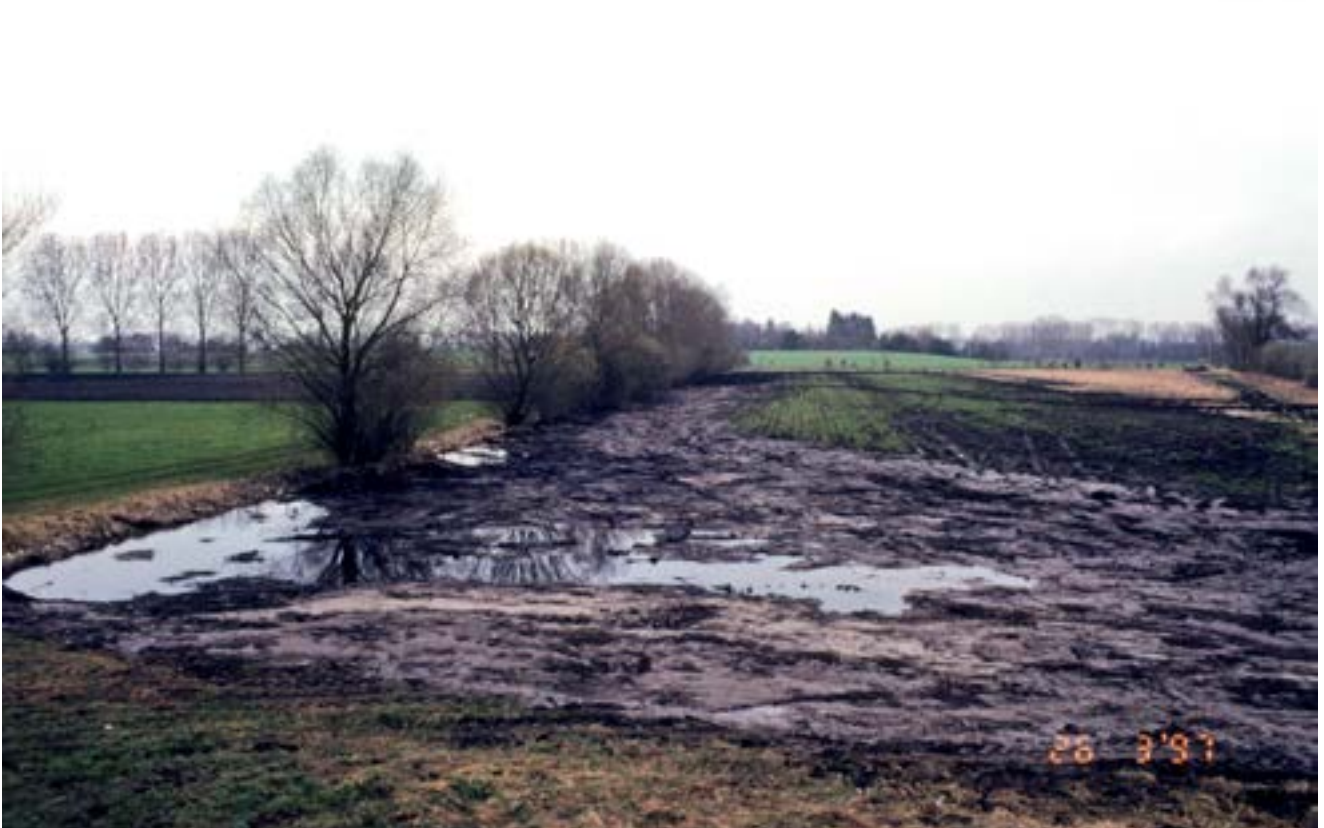
Grabenabflachungen mit Flachmulden im Gebiet zwischen Gundelfinger Moos und Brenzaue mit späterer Grünlandeinsaat. In den Folgejahren wurden die Büsche zur Erhaltung der offenen Wiesenlandschaft entfernt.
