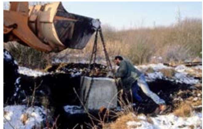
Einbau des Mönchsbauwerkes ▲ Wiedervernässter Torfstich nach Entbuschung ▼
