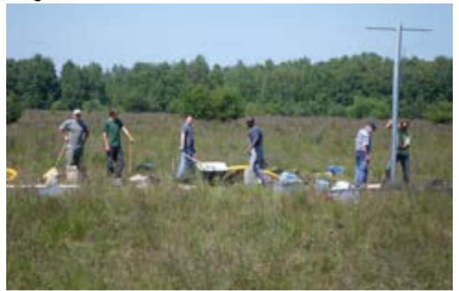
Bau einer Bodenfeuchtemeßstation zur ergänzenden Beweissicherung der Nauwasser-Einleitung ▲
