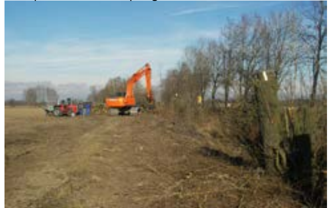
Biotopverbesserung: Entfernung von Hybridpappeln und Uferabflachung an Altwasser in der Brenzaue ▼
