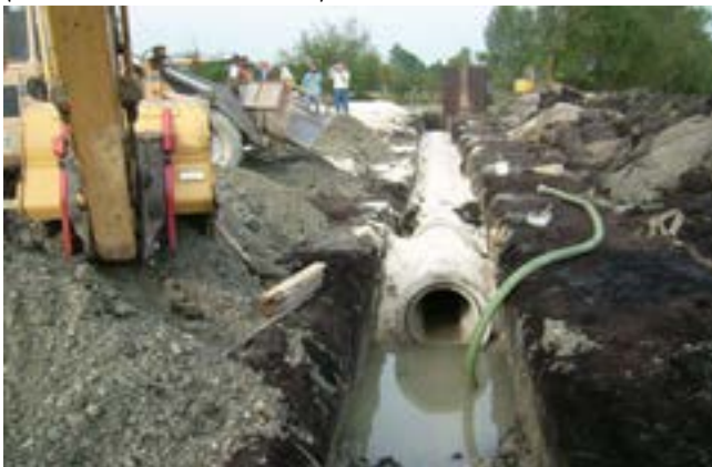
Bau der Nauleitung: Rohrverlegung, Bau eines Revisionsschachtes, Führung mit Kreistag Günzburg und Entnahme von Thymian-Soden auf der Bautrasse zur Verpflanzung (im Uhrzeigersinn)
