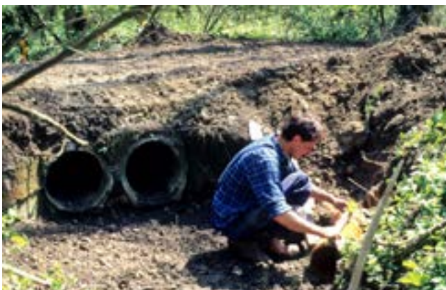
◀ Ehemalige Altwässer, die aufgrund ausbleibender Hochwässer und fehlender Flussdynamik abgeschnitten bleiben, drohen auszutrocknen: Im Falle der „Laiberlache“ im Nauwald konnte dies durch Optimierung der ehemaligen Ausströmöffnung verhindert werden. ▶
