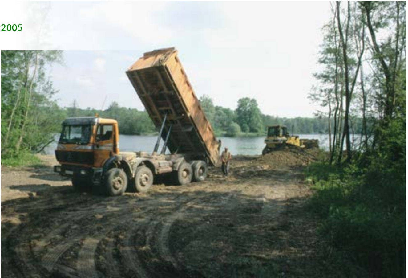
Wiederverfüllung des Aschau-Sees ▲ und Bau eines Amphibien-Biotops in Offingen ▼ ▼
