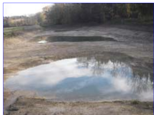
Abb. 39: Amphibienbiotop am Offinger Auwald: während der Bauphase (oben) und bei Fertigstellung (unten).
