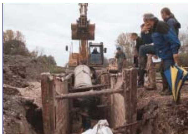
Abb. 11: Bau der Rohrleitung unter den kritischen Augen von Vertretern des Fachbeirates der ARGE Donaumoos.
