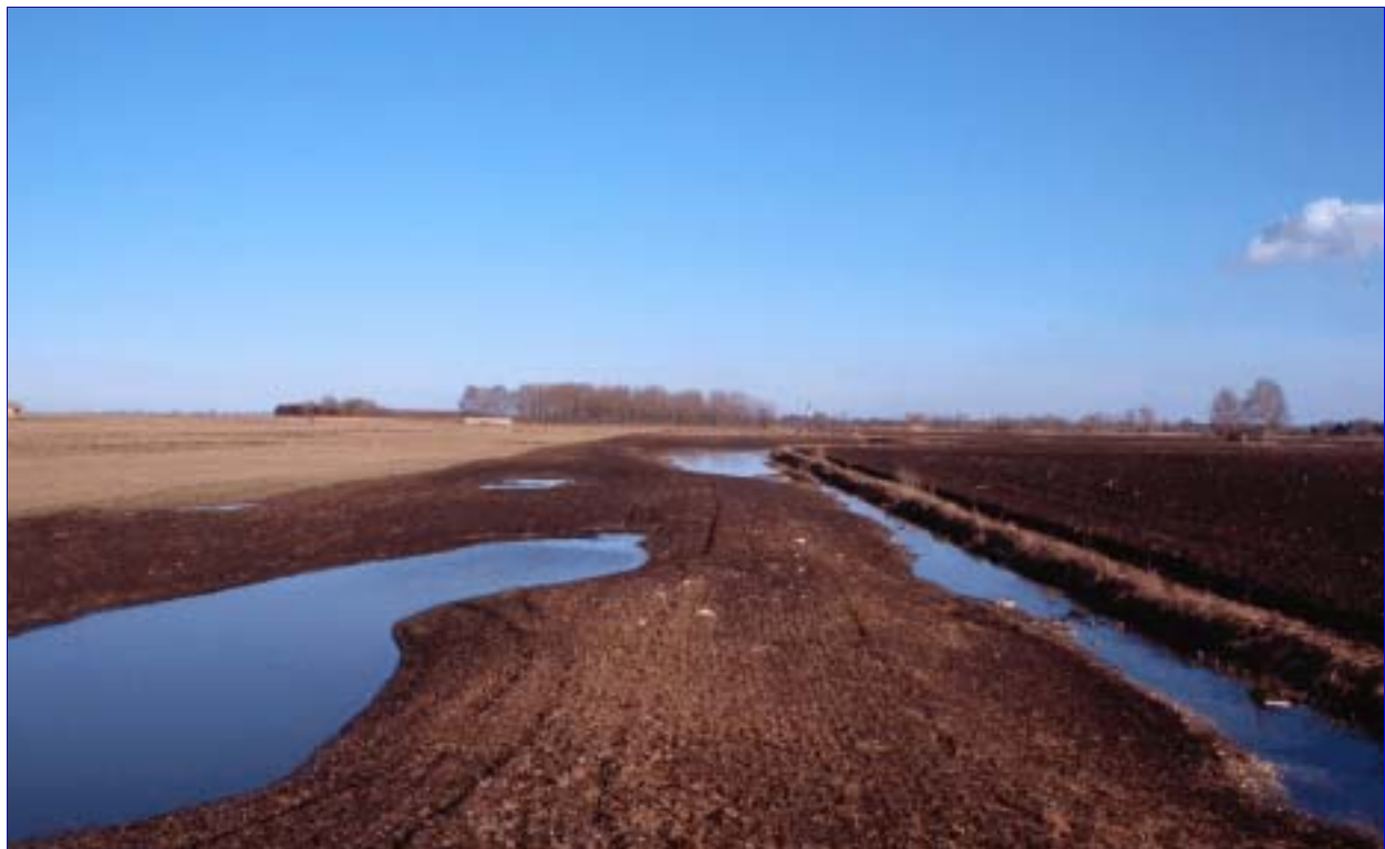
Abb. 22: Einseitige Grabenabflachung und Feuchtmulden nach Beendigung der Baumaßnahme.
